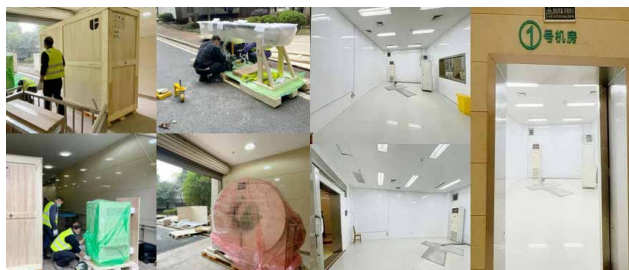
拆箱初步安装
