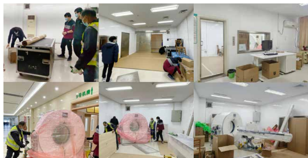
安装工具箱、CT设备入场
